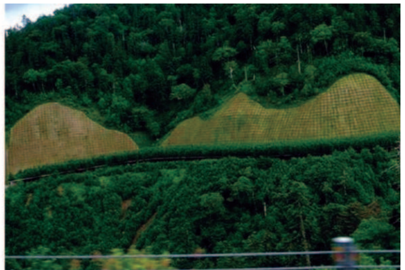
Mynd 10.16. Verkfræðilegar aðgerðir til að hamla skriðuföllum á nýgerðan veg um hálendi Hokkaídó-eyju í Japan. Japanir reyna einnig að halda í öflugra skógarhulu í fjallshlíðum til að minnka hættu á skriðum.
