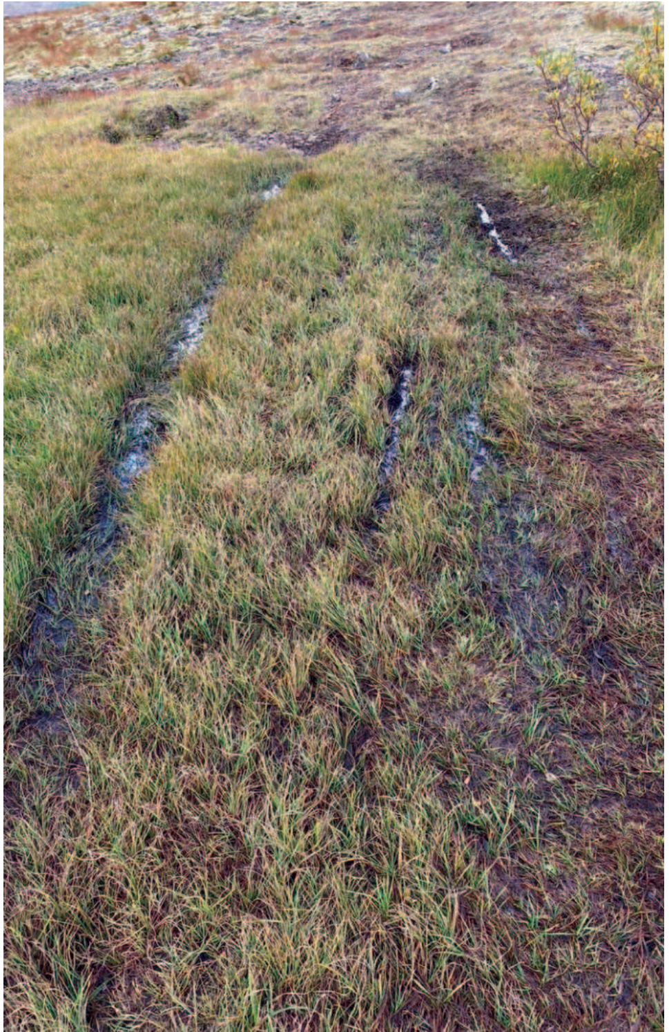
Mynd 12.20. Skemmdir vegna gangandi og hjólandi fólks á fjölfarinni leið yfir votlendiskafla. Stígurinn er farinn að „breiðast út“ með tilheyrandi skemmdum á stóru svæði. Hér væri æskilegt að krækja hjá votlendum eða leggja timburgólf yfir það. „Betri er krókur en kelda.“
