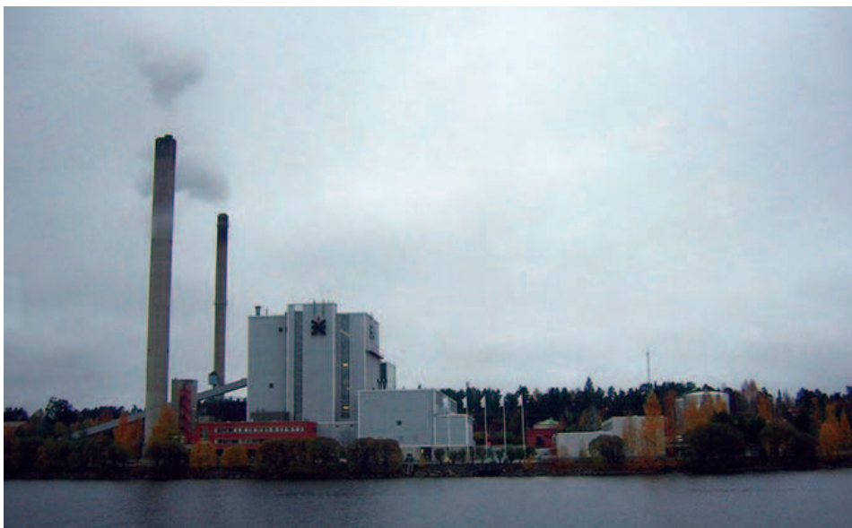
Mynd 9.12. Orkuframleiðsla með mó í Finnlandi. Orkan er notuð til húshitunar og rafmagnsframleiðslu. Heildaraflíð sem fengið er með móbrennslu í Finnlandi nemur nokkur hundruð MW. Framleiðslunni fylgir mikið rask á vistkerfum og gríðarleg losun gróðurhúsalofttegunda – hún er því mjög umdeild. Mynd: Wikipedia – opinn aðgangur (public domain).
