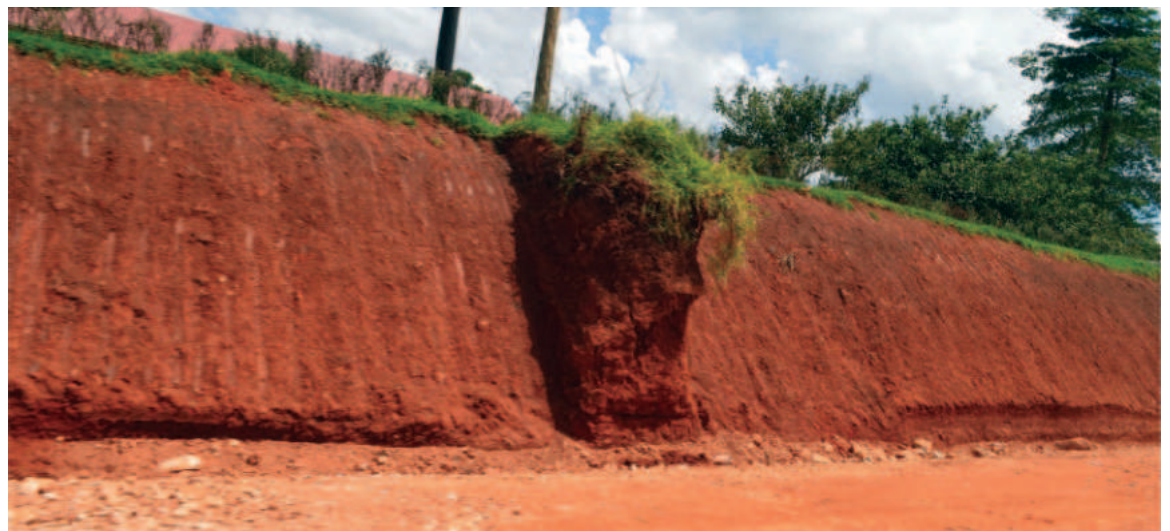
Mynd 9.9. Djúp hitabeltisjörð í Úganda. Í raun er moldin á þessum stað mun dýpri en hér sést. Mikil er af járn- og álsteindum í moldinni. Á þessu svæði er víða verið að þurrka mold til að búa til múrsteina.
