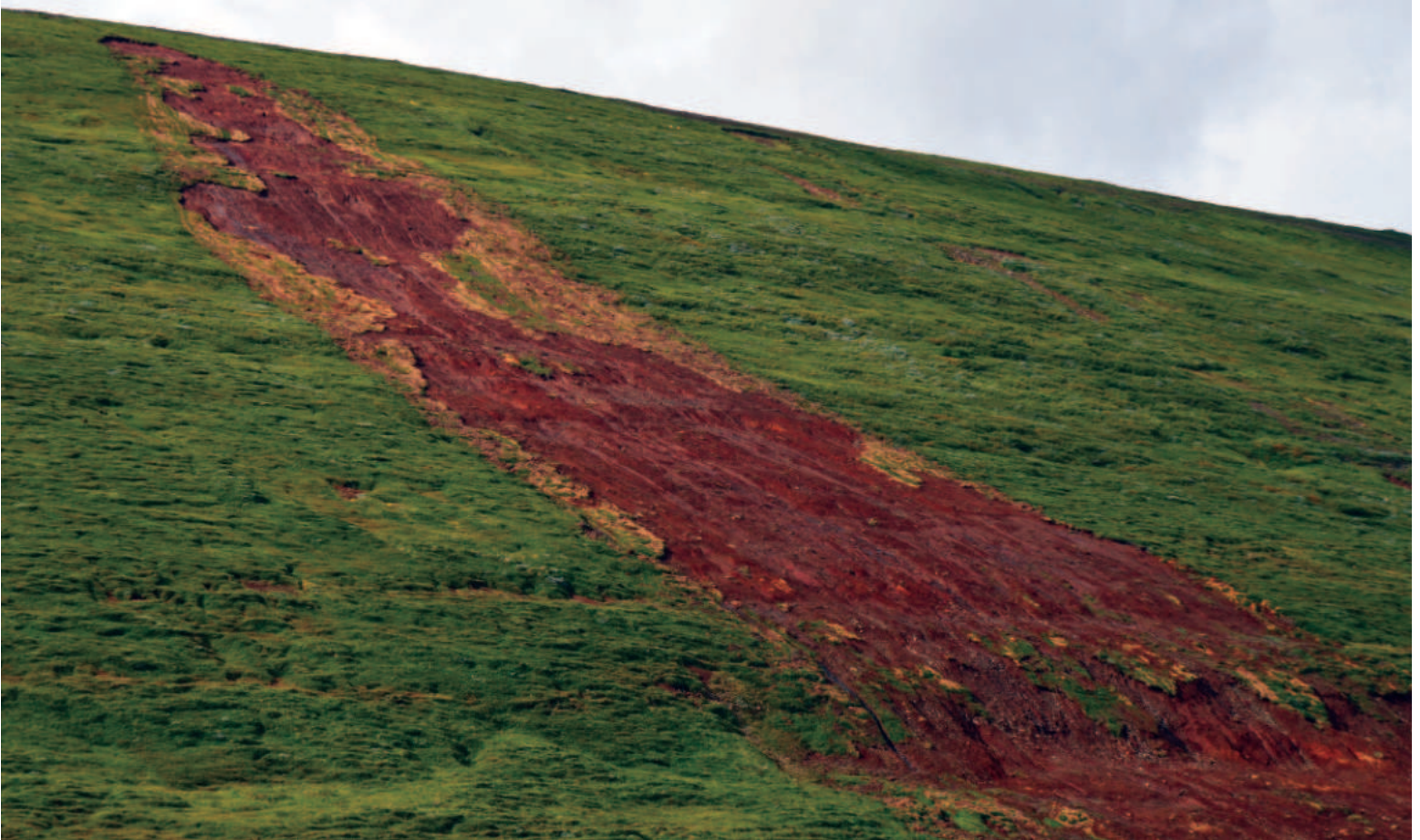
Mynd 6.9. Skriða í Út-Kinn við Skjálfaflóa sem féll haustið 2021. Upptökin eru þar sem siltrik moldin er þykk í miklum halla. Við þær kringumstæður safnast oft mikill snjór sem hripar inn um sprungur þegar hann þiðnar. Ofsafengið regn og þýða auka á skriðuhættu við þessar aðstæður.
