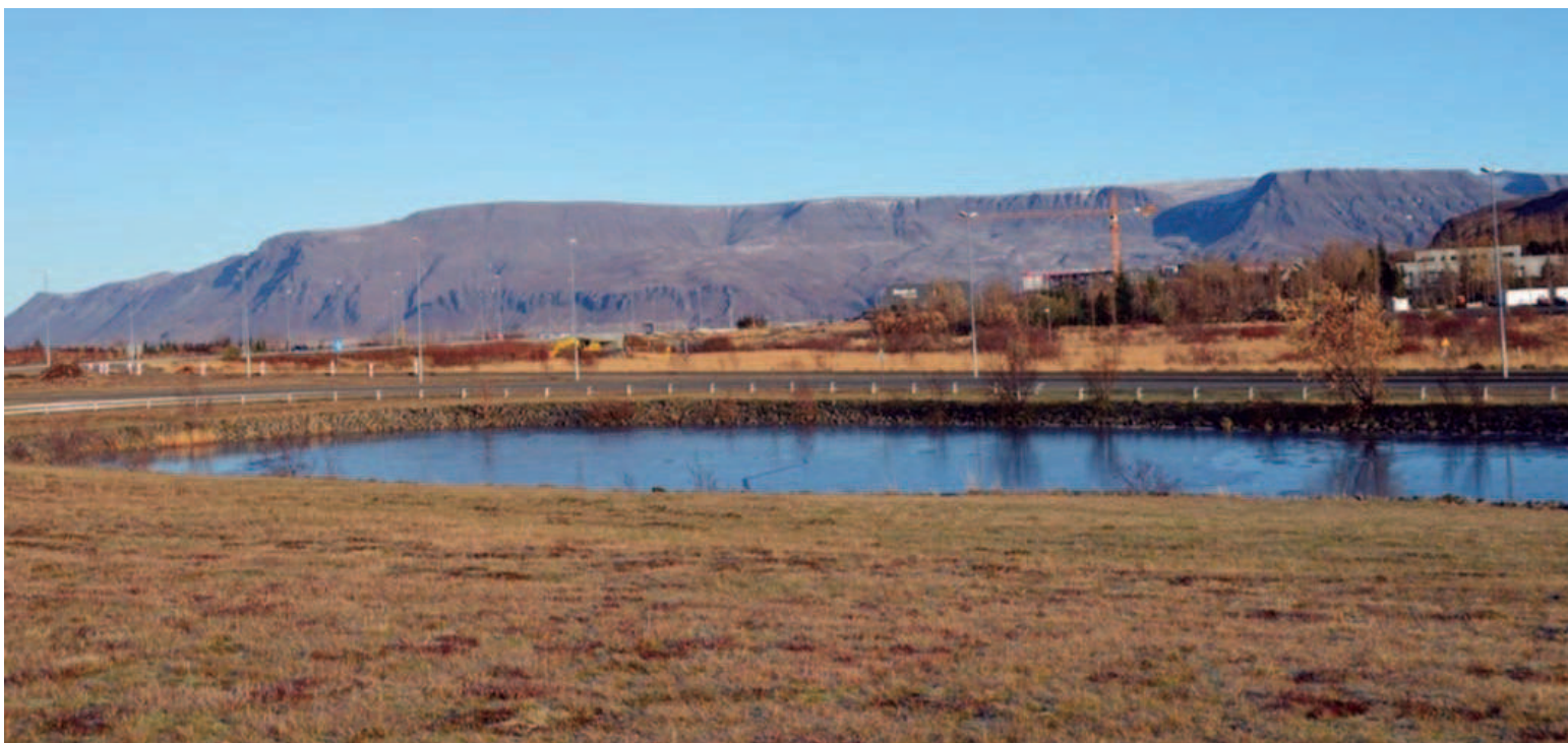
Mynd 4.13. Settjarnir til að vernda vatnasvið og ósasvæði Úlfarsár komi til mengunarslyss við hin miklu umferðarmannvirki á mótum Grafarholts og Vesturlandsvegur í Reykjavík. Bætt þekking á vatnshag stuðlar að mengunarvörnum og vatnsvernd af þessu tagi í auknum mæli hérlendis.
